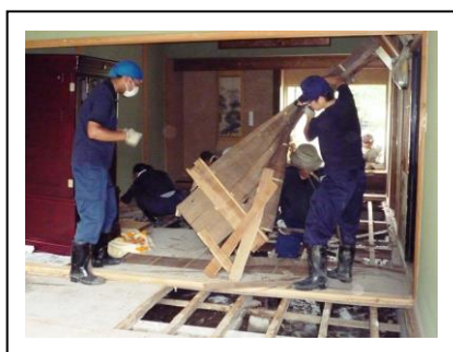
床上浸水した家は床板をはがし洗浄・消毒
