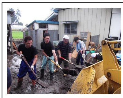
重機を使って流れ込んだ土砂をかき出す
